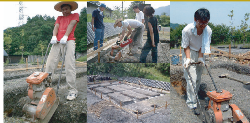
【砂利を敷きつめ、締め固める】
