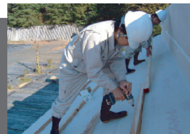
屋根下地取り付け
