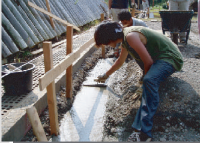
捨てコンクリート打設
