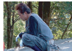
武井板金 武井さん 屋根工事をご指導いただいた
