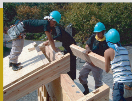
屋根面をつくり上げる
