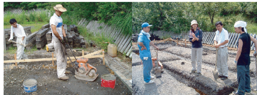
【砂利を敷きつめ、締め固める】
