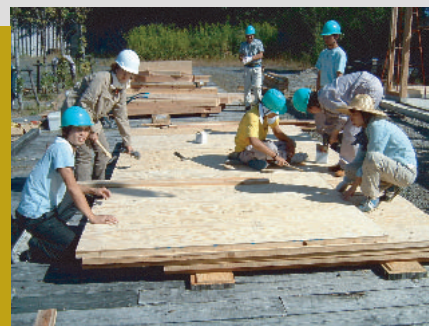
屋根面パネルをつくる
