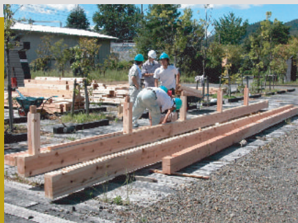
合成梁を組み上げる
