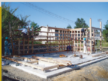
壁を立ち上げる
