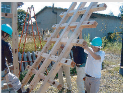
格子壁を組み建てる
