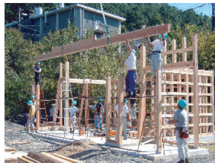
大開口部を組み上げる
