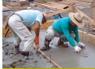
コンクリート打設1度目
