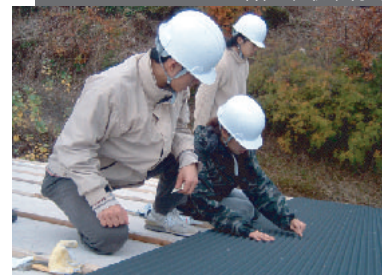
屋根葺き作業
