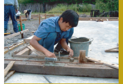
コンクリート打設2度目
