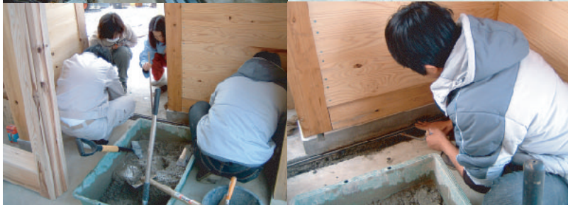
レール設置、定着
