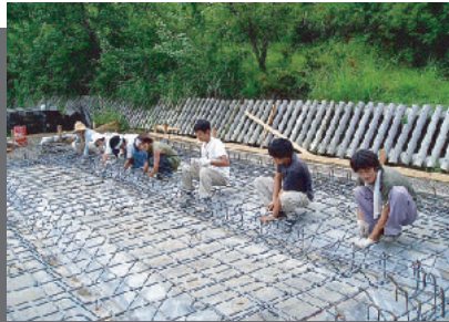
鉄筋組み
