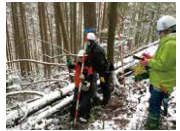
写真⑥ 周辺を観察し作業道線形を決めていく
