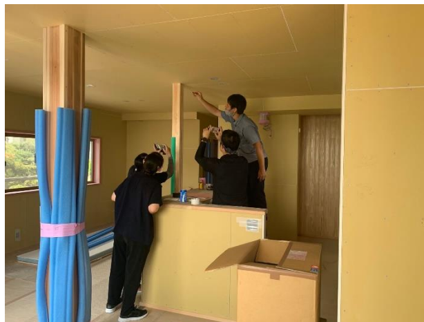
図3 気密測定での現状確認の様子(工務店の担当者立ち合いのもと)
