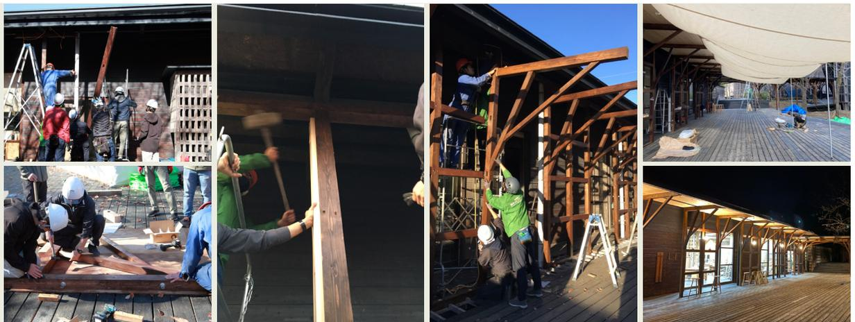
【左上・左中写真】格子の中心の柱を既存の軒下に建て入れ、横材を差し、樹状柱を地組して建て込んだ。格子の角部の仕口には、伝統的な接合方法である「びんた伸ばし」を用いた。【左下写真】方杖の接合部は木構造用ビスを用い強度を確保した。【右上写真】タープ設置時の様子。やわらかい光が心地よい。木工のグリーンウッドワークなどの野外制作時に役立つ。【右下写真】照明設置時の様子。人感センサーで自動点灯する。これまで照明が無く夜間は真っ暗だったが、明るくなった。
