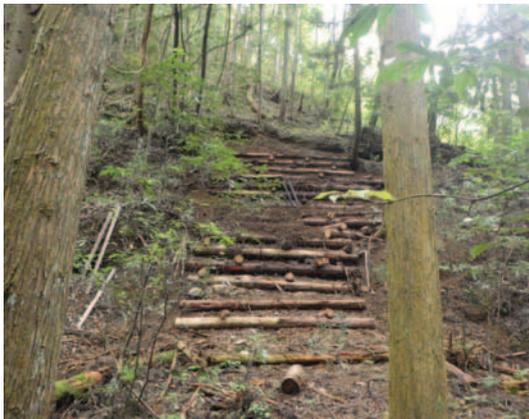
写真-1 完成した丸太組工(全景)
