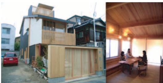
写真1 岐阜県産スギ製材ラーメン構造による住宅
