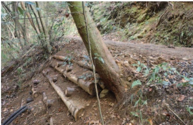
写真-3 補修した路肩(施工後)
