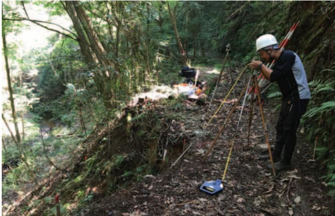
写真-2 路面水により侵食した路肩(施工前)
