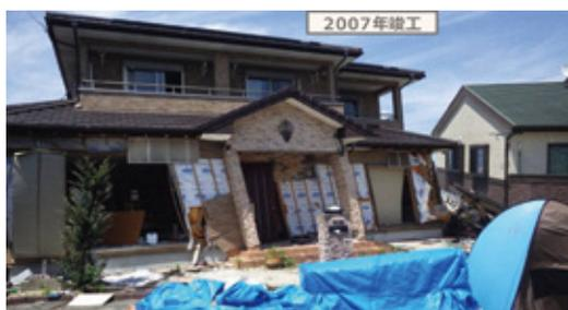
写真-2 新しい木造住宅の被害
