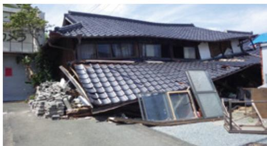
写真-1 比較的古い木造住宅の倒壊
